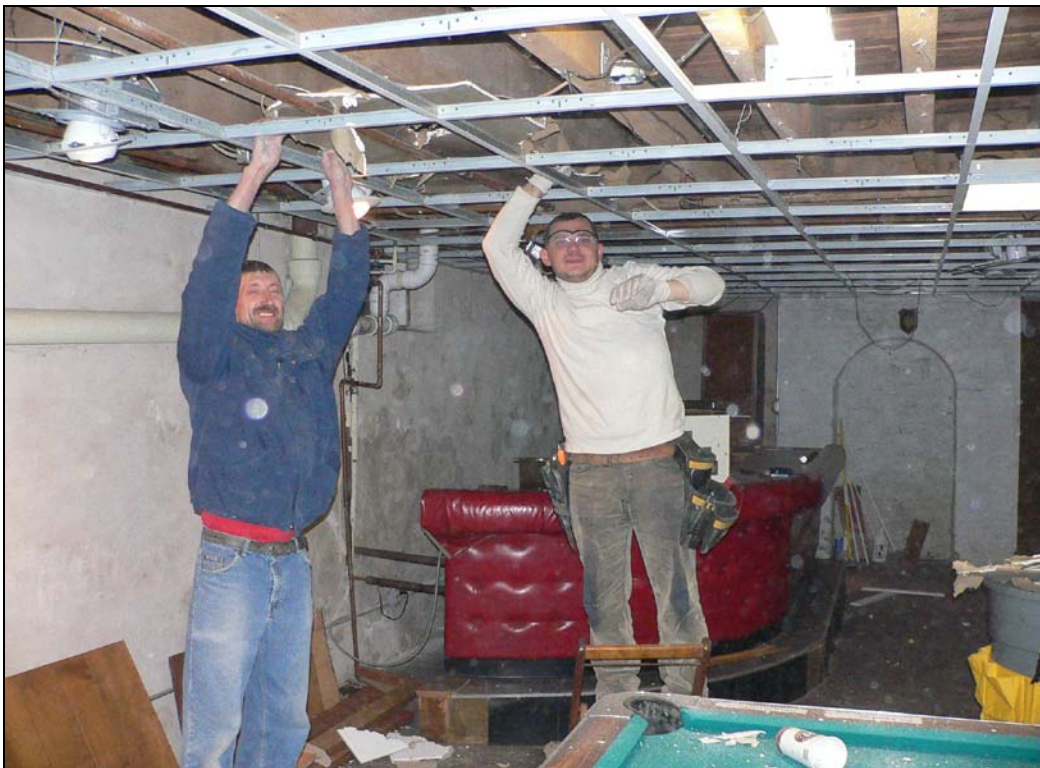
Ремонтні роботи у відпочинковому клубі виконують Ігор Горбач та Андрій Яцунік.
